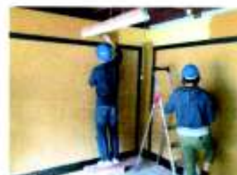
漆喰塗り(屋内)
