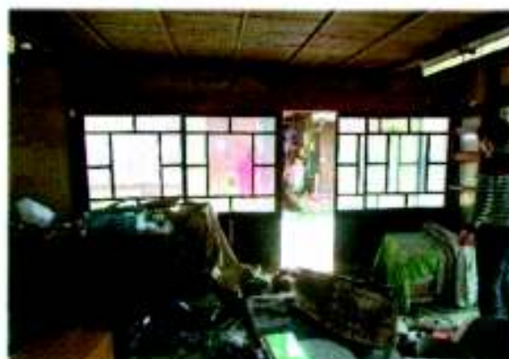
改修前の空き家の内観
