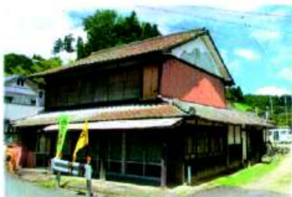
改修前の空き家の外観
