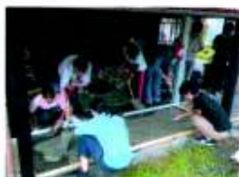
屋外モルタル打設
